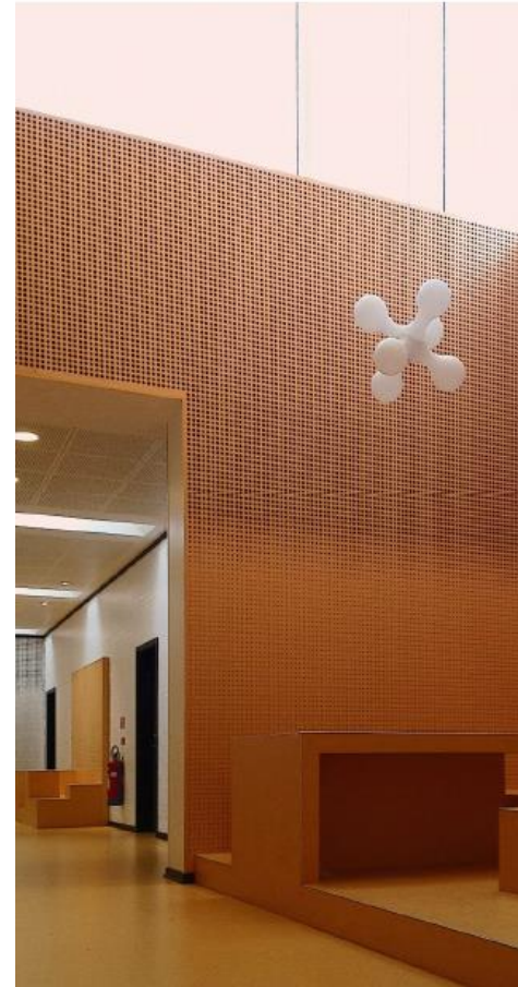
Dyvekeskolen: lysniche med pillesikret akustik
